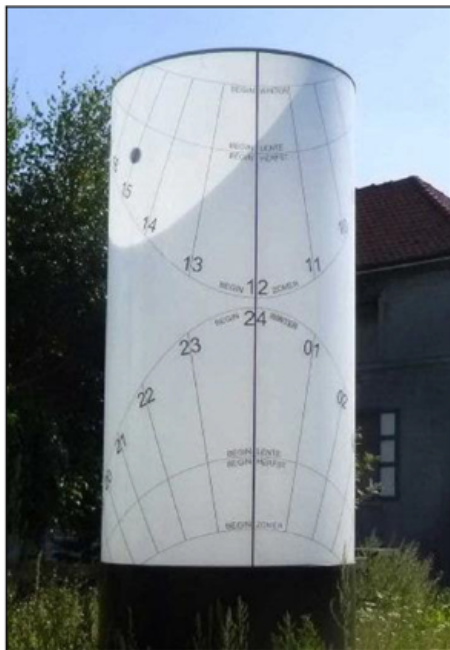
Fig. 2. De cilinderzonnewijzer in Humbeek. Het bovenste lijnenstel is de eigenlijke zonnewijzer, op het patroon daaronder wordt 's nachts door een projector een lichtvlek geworpen. Bron: www.wijzerweb.be .
