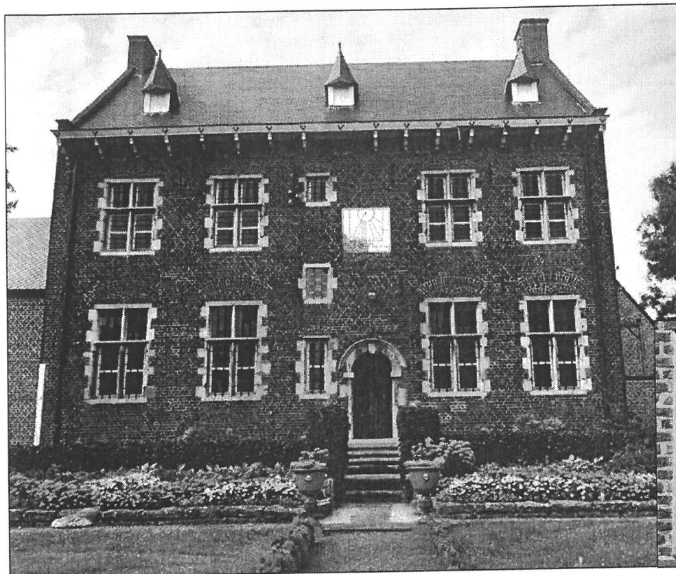
Foto 1: De achtergevel van de Oude Pastorie. Het tafereel van de zonnwijzer is duidelijk zwaar verweerd. Op de inzet ziet men de nieuw gecementeerde grondlaag van het tafereel.
