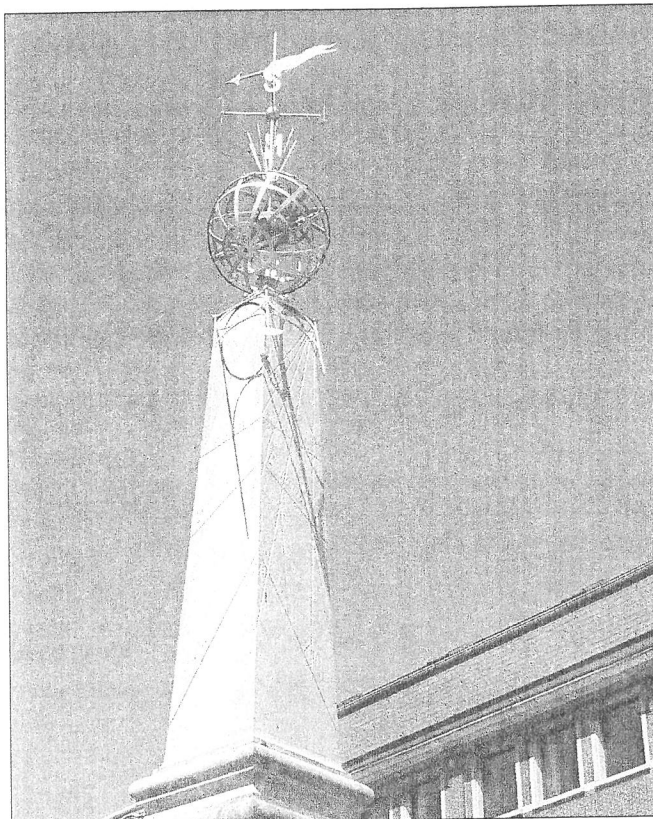
De obelisk gezien vanuit het zuiden; de zuidelijke rib is de middaglijn; op de beide zijvlakken zijn zonnewijzers geconstrueerd. Let ook op de (enigszins verdraaide) armillairsfeer met bliksemafleider en windwijzer (eigen
