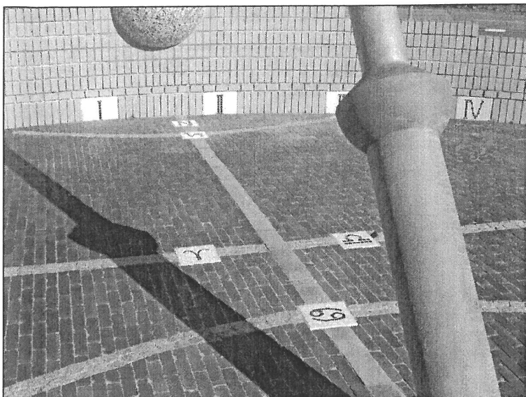
Fig. 7. De meridiaanlijn treft de uurschaal op 13:38 uur, passend bij de lengtecorrectie van 9\frac{1}{2}^\circ . Er zijn slechts drie datumlijnen aangebracht. De foto is genomen op 9 oktober; de schaduw van de index valt al even ten noorden van de equinoxlijn.
