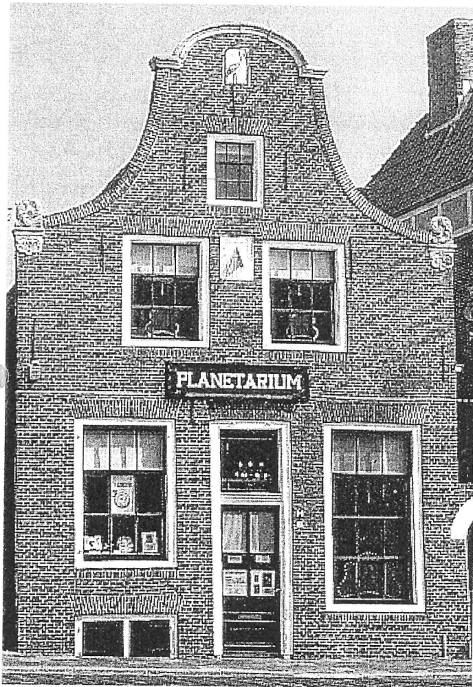
De voorgevel van Eise Eisinga's planetarium te Franeker (met verticale zonnwijzer tussen de vensterramen van de eerste verdieping).
