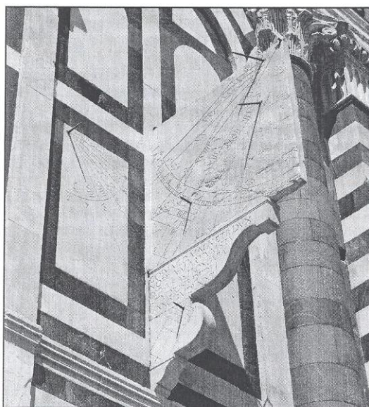
Een kijkje op de zonnewijzers op de rechterzijde van de voorgevel. De haaks op de muur staande constructie bevindt zich nagenoeg exact in het meridiaanvlak.
