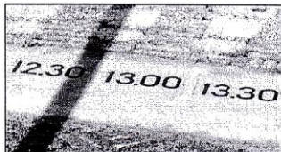
Fig. 5. Kunststof cijfers in betontegels vormen op deze foto al 12 jaar een duurzame tijdschaal voor een pleinzonnenuijzer in Amersfoort (NL).
